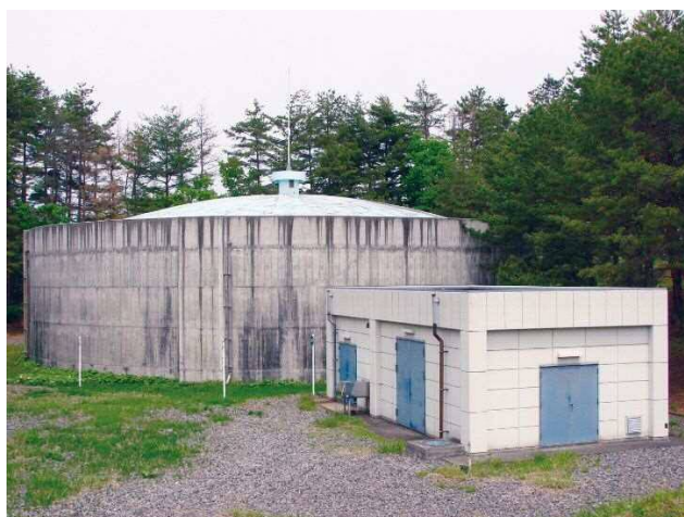
上ノ山配水池
