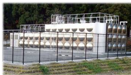
宮川第 1 ポンプ場
