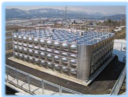
西海枝配水池
