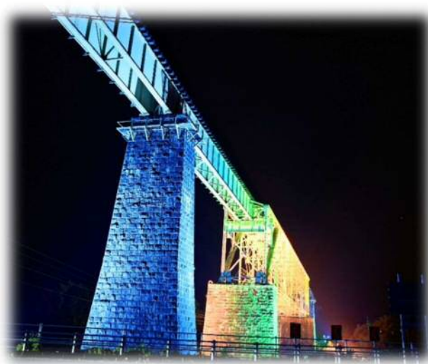
山都(一ノ戸川橋梁)
